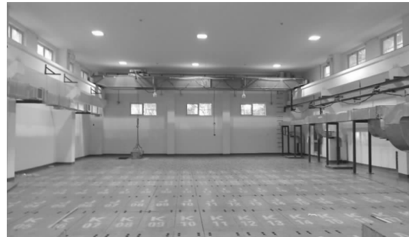
图 4 改造后废物库行车现状
