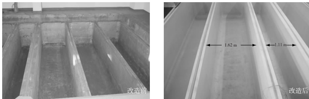
图 5 改造前后贮槽内部对照
